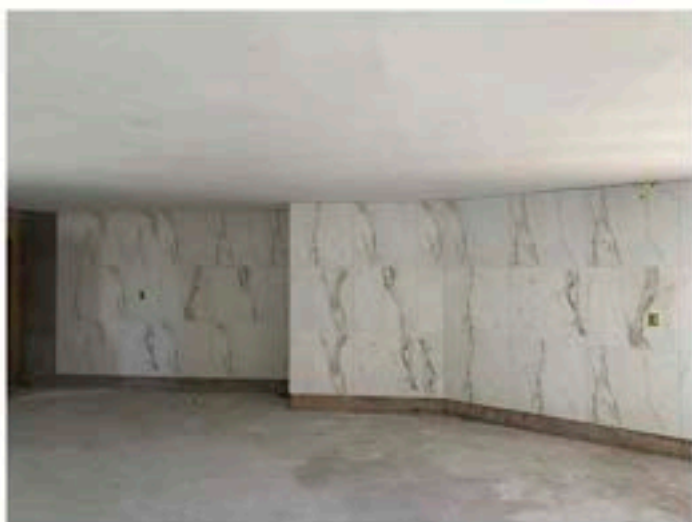
Reforma da sede da SEFAZ no Centro Administrativo
